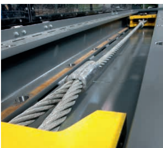
Prüfung von Drahtseilen
